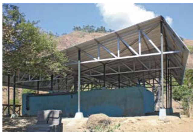
Gemeinsames Werk der Bevölkerung von Muntigunung in Nordost-Bali: der Bau eines kommunalen Wasserreservoirs.
