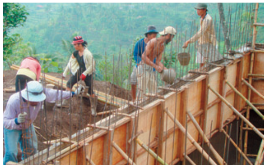
Neben den halboffenen Rundzisternen bei den einzelnen Familien wird jetzt in jedem Dorf das Regenwasser zusätzlich in gedeckten, grossvolumigen kommunalen Reservoirs gesammelt. Hier der Bau eines Reservoirs in Kulkul mit einem Fassungsvermögen von nahezu 300 Kubikmeter.
